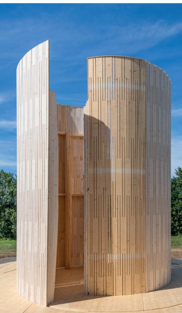
“ Les panneaux CLT sont entaillés selon la méthode “lattice hinge”. La courbure est obtenue par une mise en torsion des bandes verticales...”
