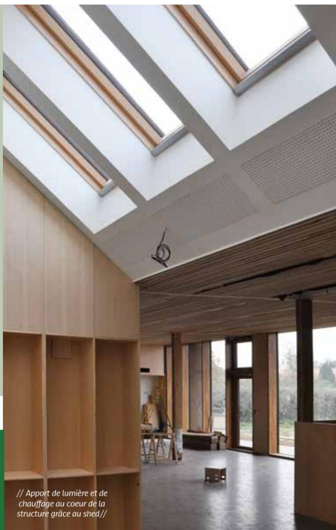
// Apport de lumière et de chauffage au coeur de la structure grâce au shed //
