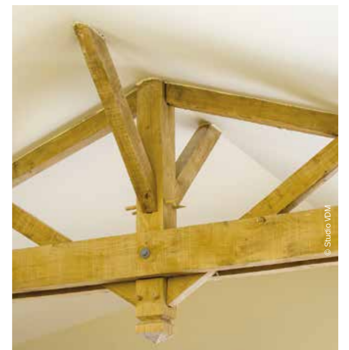
// Charpente en chêne //
