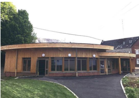
Figure 17 : Exemple d'une réalisation mise en avant sur le site de la plateforme Avivio : le restaurant scolaire de Trélon, dans le Nord, avec du peuplier local pour les structures poteaux-poutres et les toitures-terrasses.
