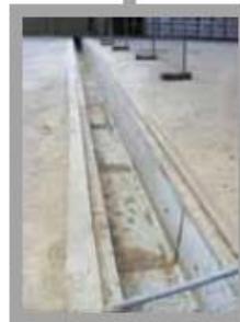
Aménagement dans la dalle béton pour le tapis roulant
