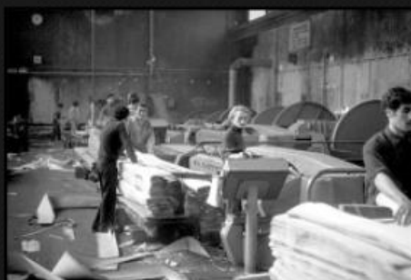
Manipulation des feuilles devant les trancheuses horizontales.
