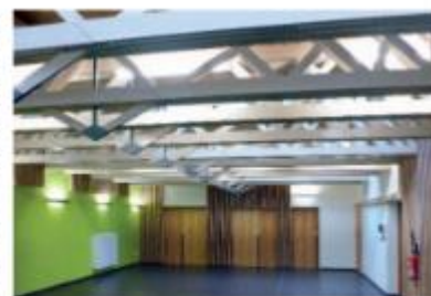
D'un aspect de 50 personnes, la salle polyvalente bénéficie d'une isolation acoustique intégrée à tous les usages, des réunions associatives aux fêtes communales.
