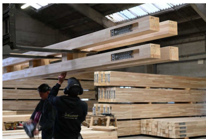
Préparation de la structure à l'Atelier d'Edwood - Photo © Atelier 9.81
