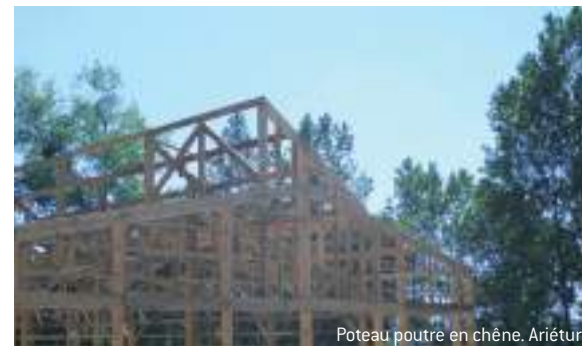
Poteau poutre en chêne. Ariétur
