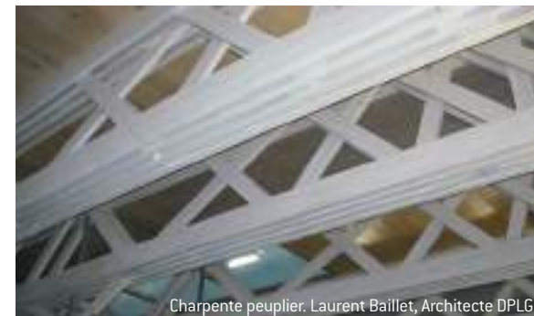
Charpente peuplier. Laurent Baillet, Architecte DPLG
